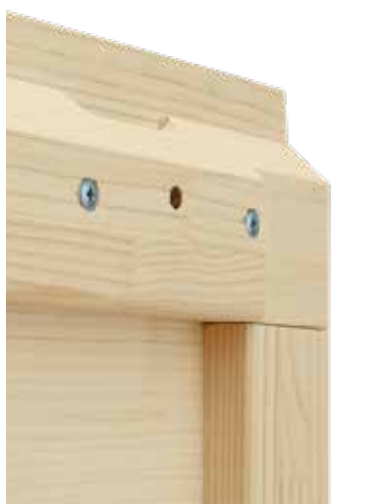
Sustiprinimas segmentų galuose
